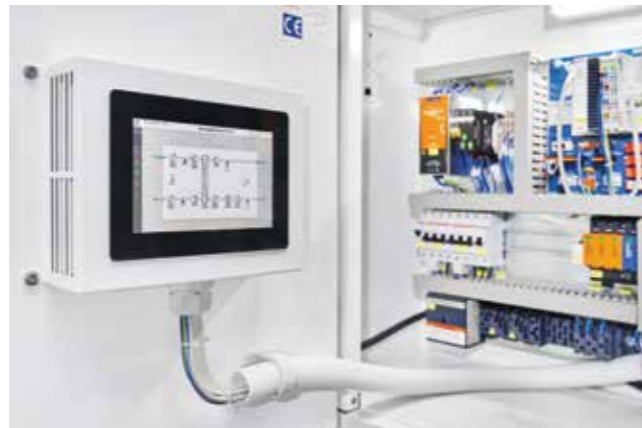
Figura 20: Esempi di sistemi di regolazione digitale di una UTA
